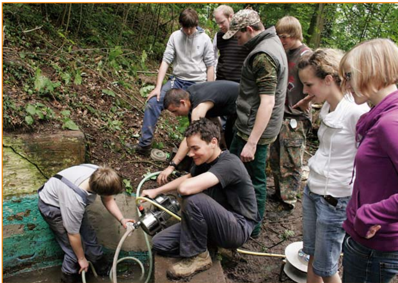
Bevor der Brunnen saniert werden konnte, musste das alte verschmutzte Wasser abgepumpt werden.
